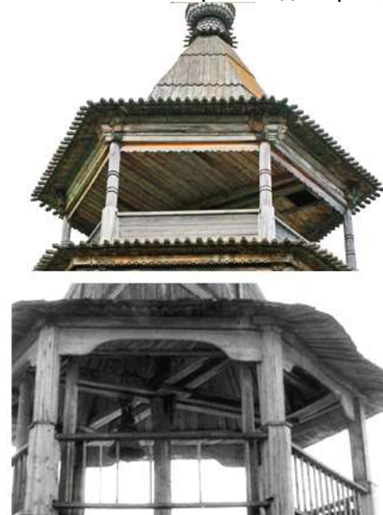
Зашивка нового шатра и вид старого
