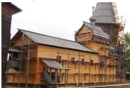
Обшивка храма досками
