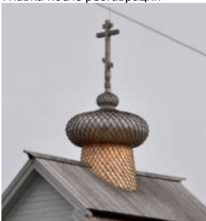
Главка после реставрации
