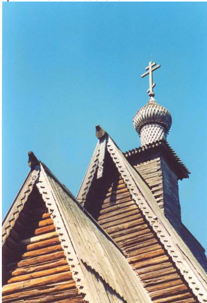
Кровли и главка на постаменте.
