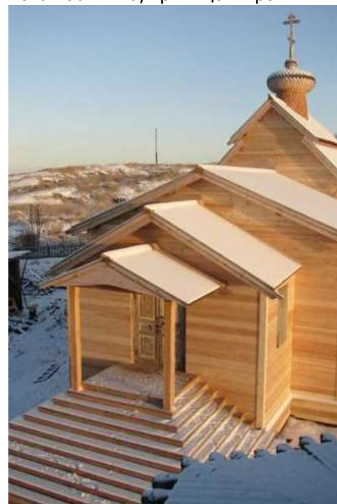
Новая обшивка, крыльцо и кровли
