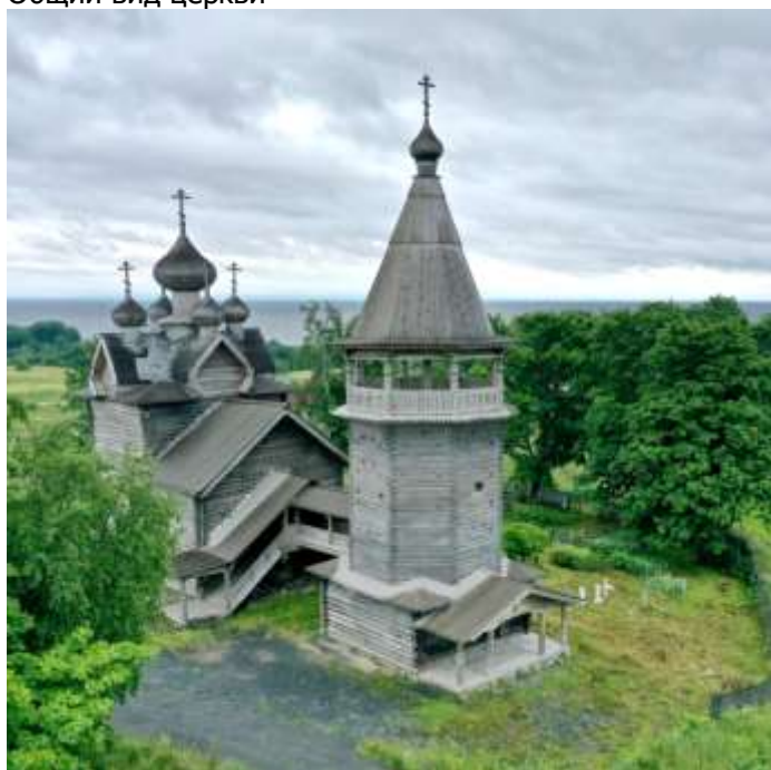
Общий вид церкви
