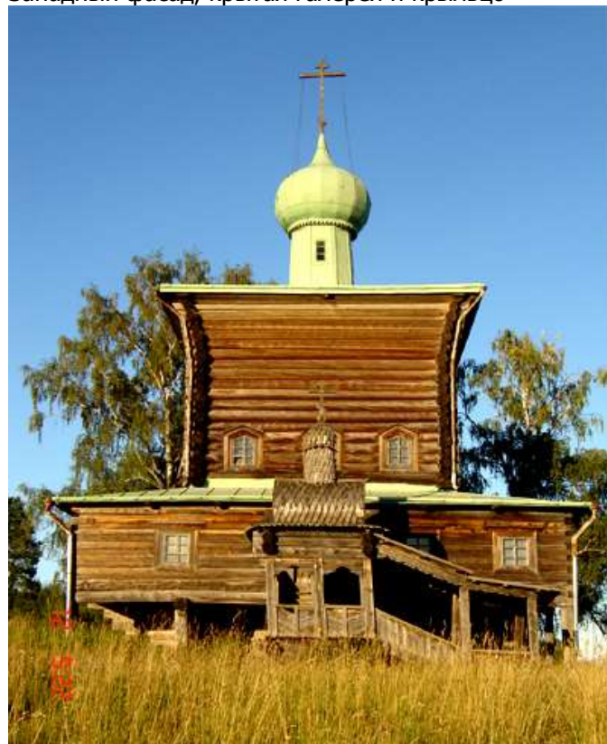
Западный фасад, крытая галерея и крыльцо
