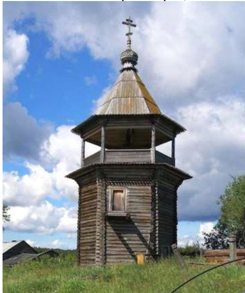
Колокольня после реставрации
